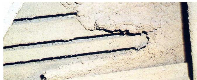
Figura - Spruzzatura dell'amianto
