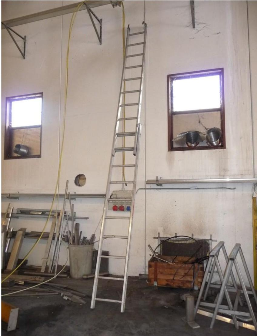
Il lavoratore, mentre operava su una scala portatile “a sfilo a sviluppo manuale”, utilizzata per smantellare una parte di impianto elettrico, cadeva da circa 5 metri di altezza per perdita di stabilità – scivolamento alla base di appoggio – della scala stessa.
