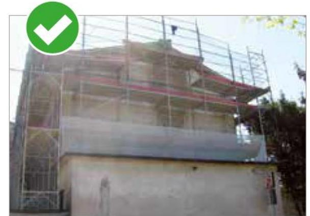
Devono essere completi in ogni parte. Dotati di parapetto con correnti superiore ed intermedio, fermapiede, chiusura di testata, piano di calpestio completo, ponte e sottoponte.
