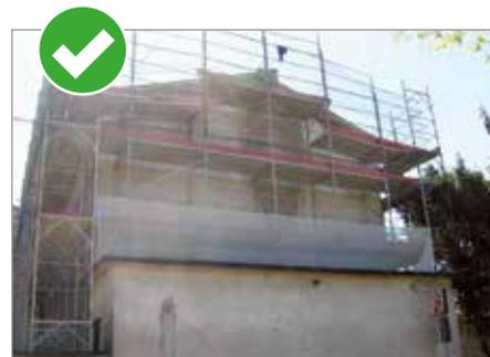
Devono essere completi in ogni parte. Dotati di parapetto con correnti superiore ed intermedio, fermapiède, chiusura di testata, piano di calpestio completo, ponte e sottoponte.
