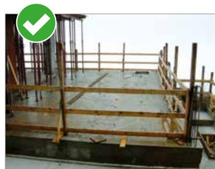
**I parapetti in legno** tradizionali devono essere realizzati con materiale che garantisca adeguata resistenza (dimensione dei montanti, presenza di rinforzi, spessore delle tavole dei correnti), devono essere presenti: il corrente superiore, intermedio e tavola fermapiede ed i montanti devono essere disposti con una distanza massima tra loro di circa 1.80 m. uno dall'altro.
