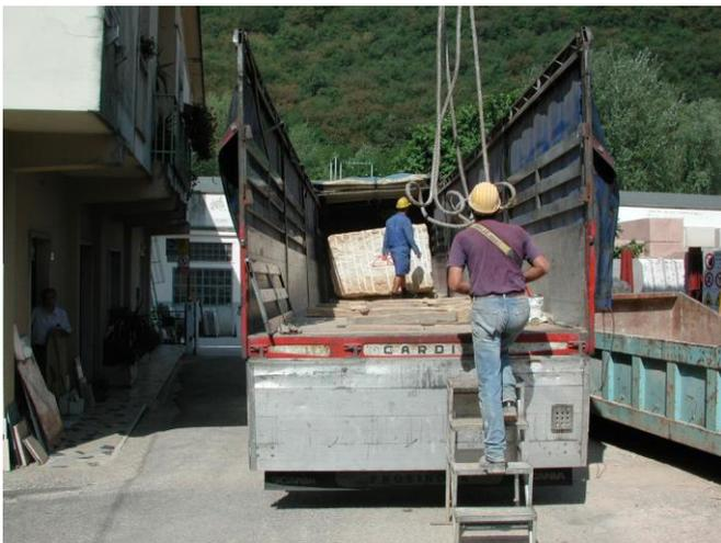
munirsi di una scaletta robusta e resistente con piedini antidrucciolo se il blocco si trova a una quota superiore al livello del pavimento (autocarro o doppio strato di blocchi),
