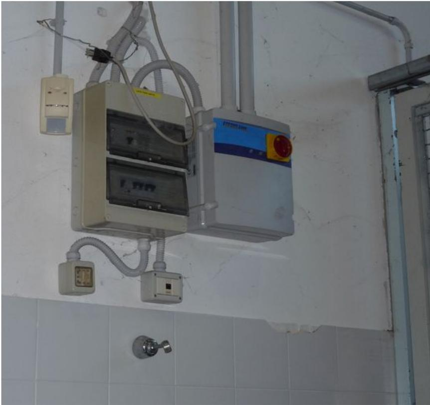
Impianto elettrico deve essere conforme alla normativa vigente in tutti i suoi componenti. Le protezioni contro il contatto accidentale (**Messa a terra coordinata con interruttore differenziale**) realizzate collegando le masse metalliche per raggiungere l'equipotenzialità. **Le stesse vanno sottoposte a collaudo e verifica periodica.**
