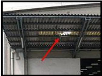
Il lavoratore cadeva da un'altezza di 6 metri a seguito dello sfondamento di una lastra di materiale plastico usata come copertura di una tettoia a sbalzo. Politrauma.
