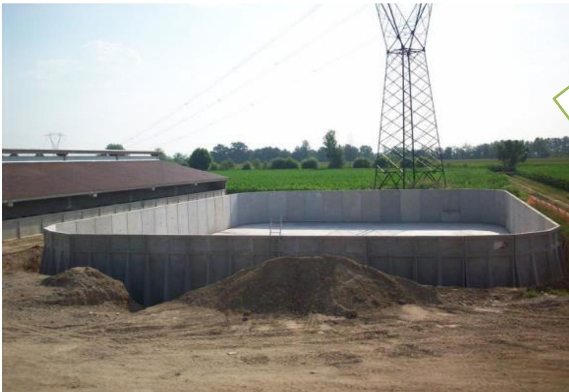
Le vasche interrato, seminterrato, le lagune, le prevasche, i pozzettoni di carico e simili devono essere dotati di recinzione perimetrale di altezza complessiva non inferiore a 1800 mm, composta da elementi non scalabili ad esempio rete metallica a maglia fitta.
