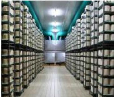
**Scaffali per la stagionatura delle forme di formaggio nelle celle frigorifere:** Nelle celle frigorifere di tipo tradizionale, la sistemazione dei formaggi avviene su scaffali fissi. Talvolta vengono anche utilizzati scaffali mobili posti su rotaie in modo che, una volta riempiti, possono essere avvicinati tra loro permettendo così, rispetto agli scaffali fissi, la stagionatura di un maggior numero di forme nello stesso spazio.
