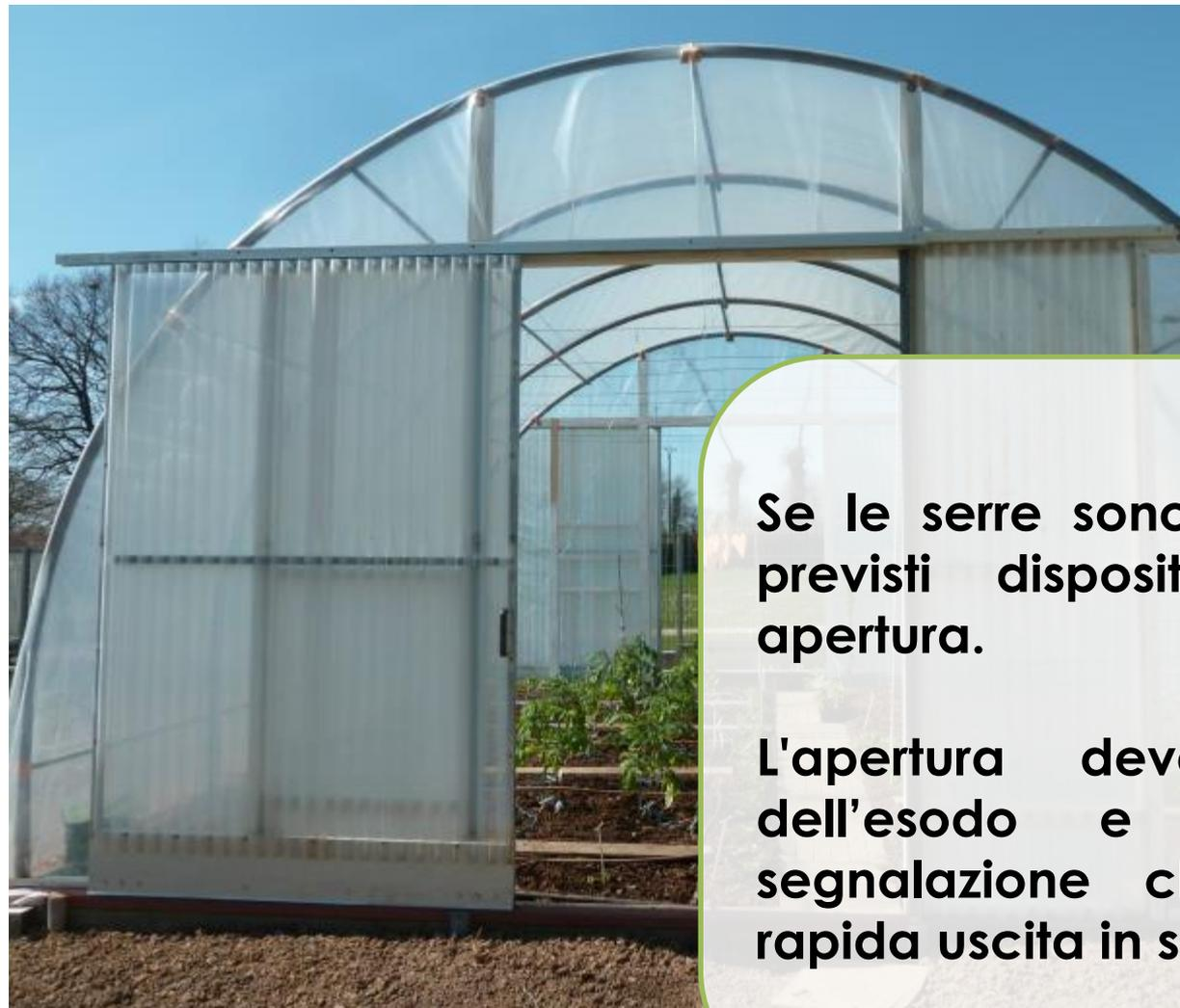
**Se le serre sono chiuse, devono essere previsti dispositivi di bloccaggio in apertura.**
