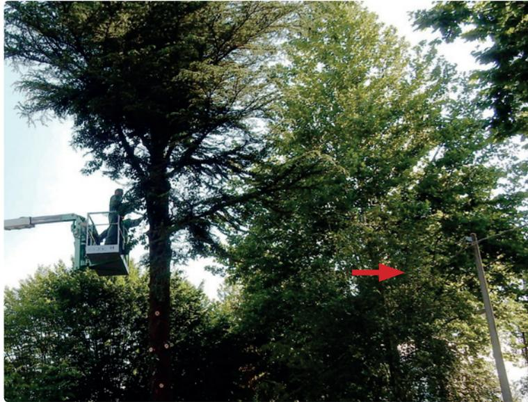
*...il pericolo di contatto con linee elettriche aeree deve essere valutato attentamente, sia durante la manovra della P.L.E., che durante la sramatura mediante utensili da taglio*
