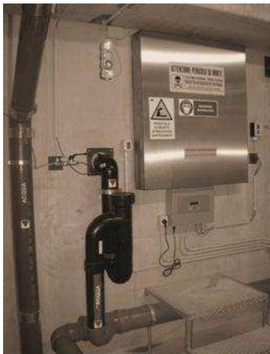
– *Corridoio tecnico*: ambiente normalmente sovrapposto ai corridoi di accesso alle celle, nel quale sono disposti gli impianti ed i macchinari di processo, quali ad esempio i generatori di azoto, gli assorbitori di anidride carbonica, i collettori di derivazione delle relative condutture, le valvole di sovrappressione. Dal corridoio tecnico generalmente sono accessibili anche i finestrini in quota delle celle.
